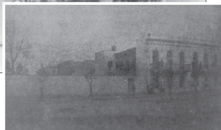
Predio en la calle Acordada (hoy Balderas). 1887 aproximadamente.
