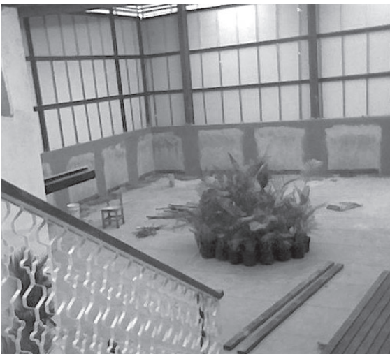
Trabajos para habilitar el salón social en el 4to. piso.
